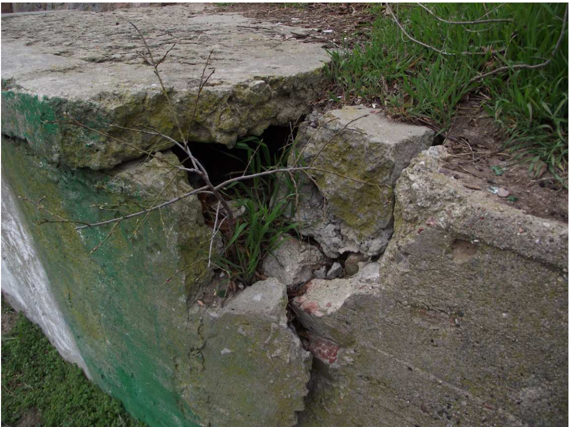
Fot.8. Połączenie z murkiem oporowym
